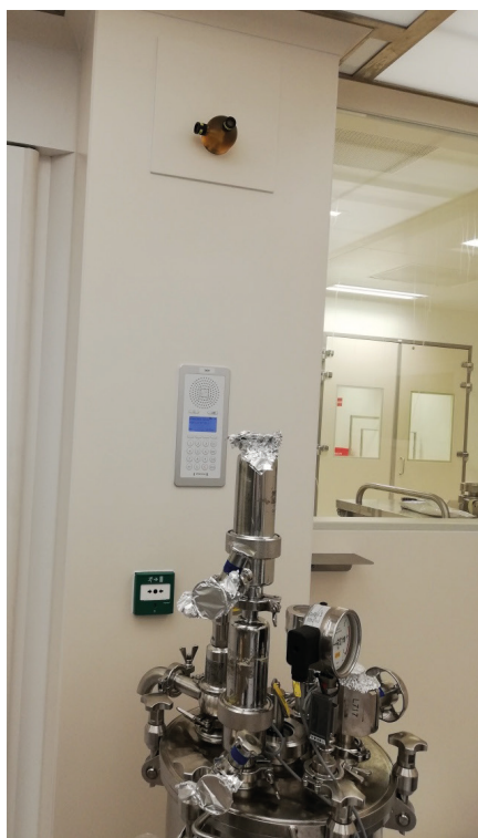
Foto: Solidfog. Cabezal con dos puntos de nebulización integrado en una pared de una zona de producción.
