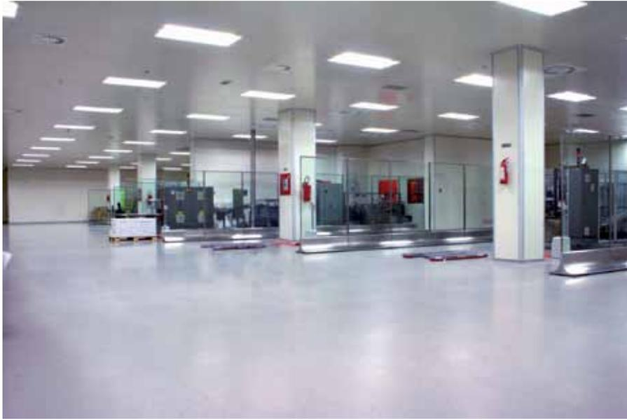
Figura 5. Resina epoxi en área de empaquetado
