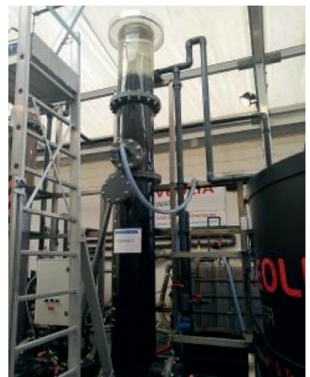
Figura 5: Columna de ensayo
