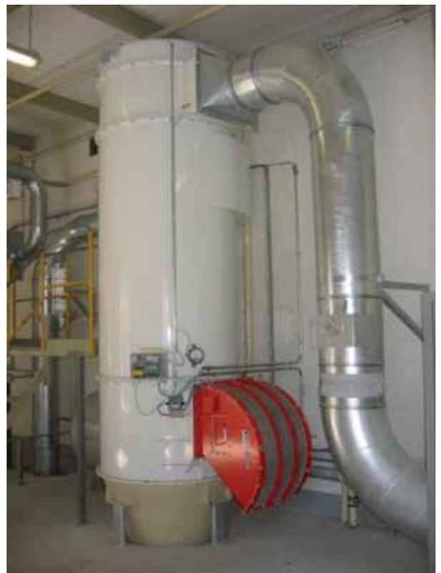
Figura 5: Filtro de captación protegido mediante venteo con apagallamas.
