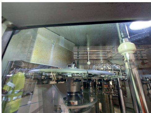
Limpieza, antes (izda.) y después (dcha.).
